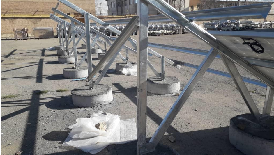
اجرای فوندانسیون سازه با استفاده از کول چاه
