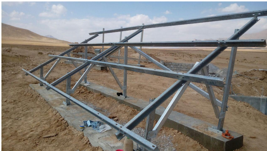
اجرای سازه بر روی فوندانسیون بتنی
