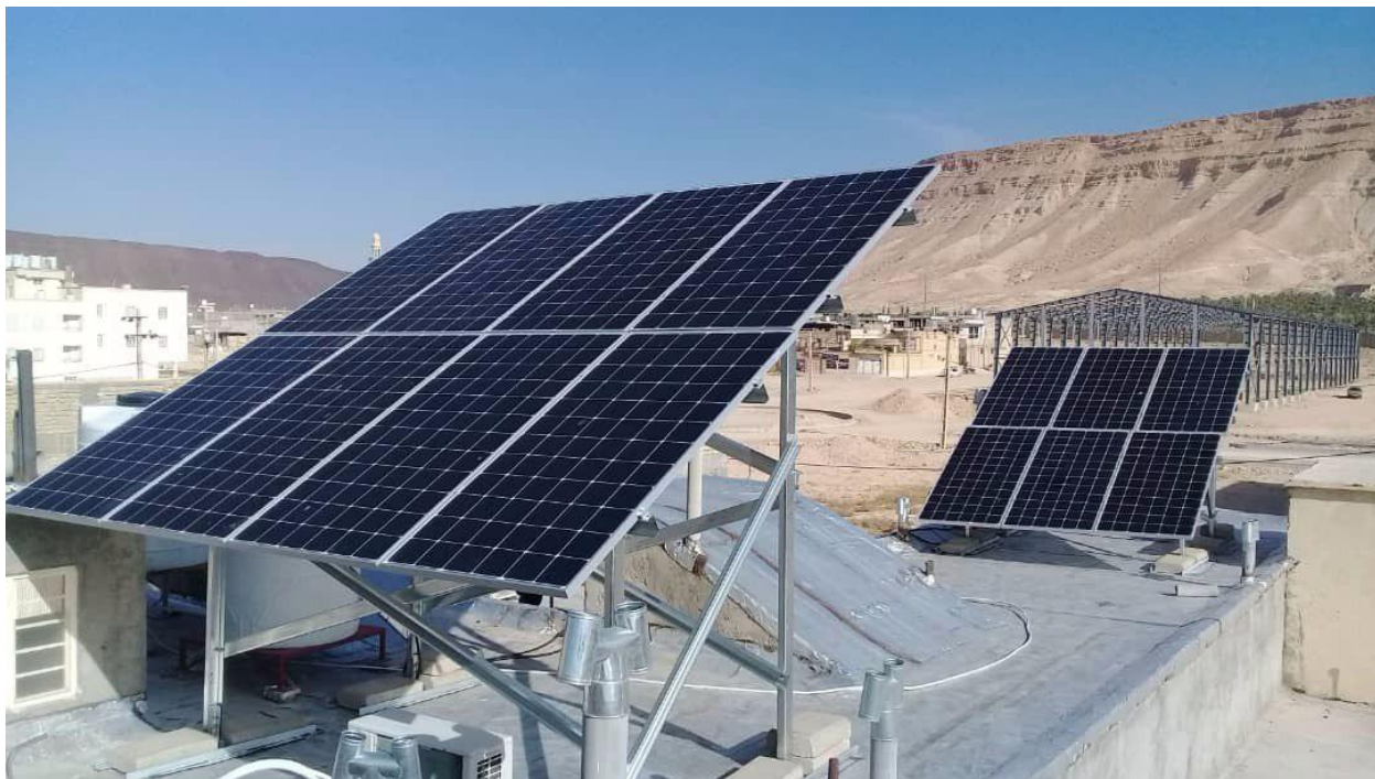
سازه 6 پنل و 8 پنل دو ردیف با تنظیم ارتفاع
