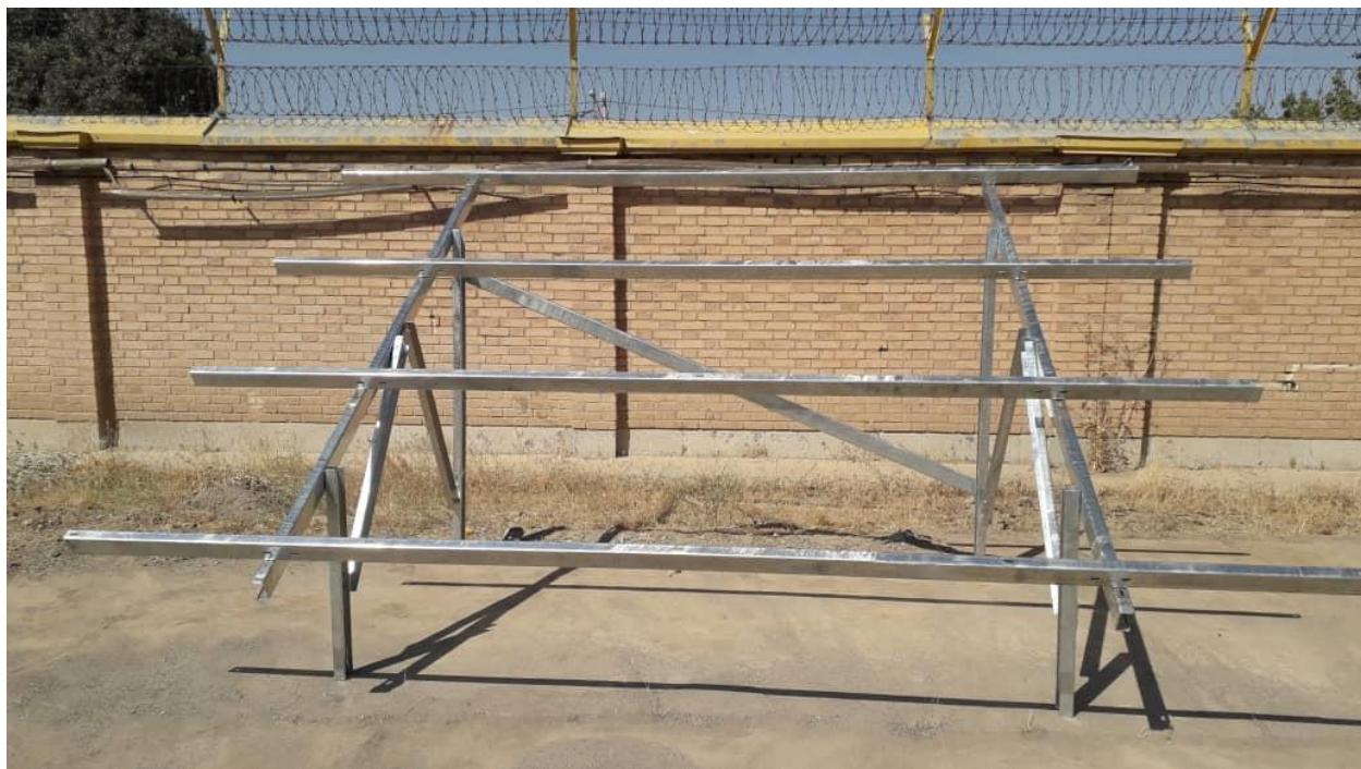
نمونه سازه 8 پنل مونتاژ شده
