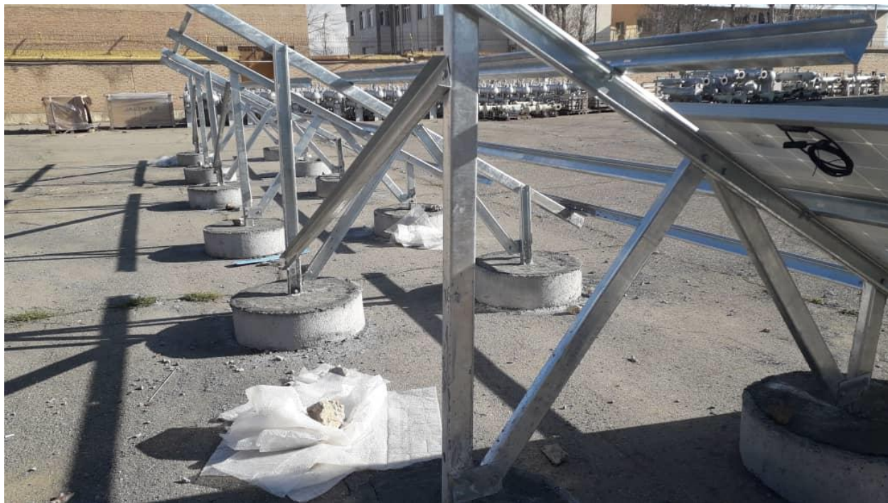
نمونه اجرا شده به صورت بتن درجا با استفاده از کول میله ای
