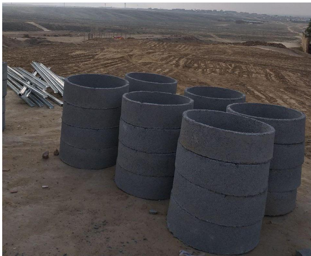
استفاده از کول میله ای به عنوان قالب بتن ریزی
