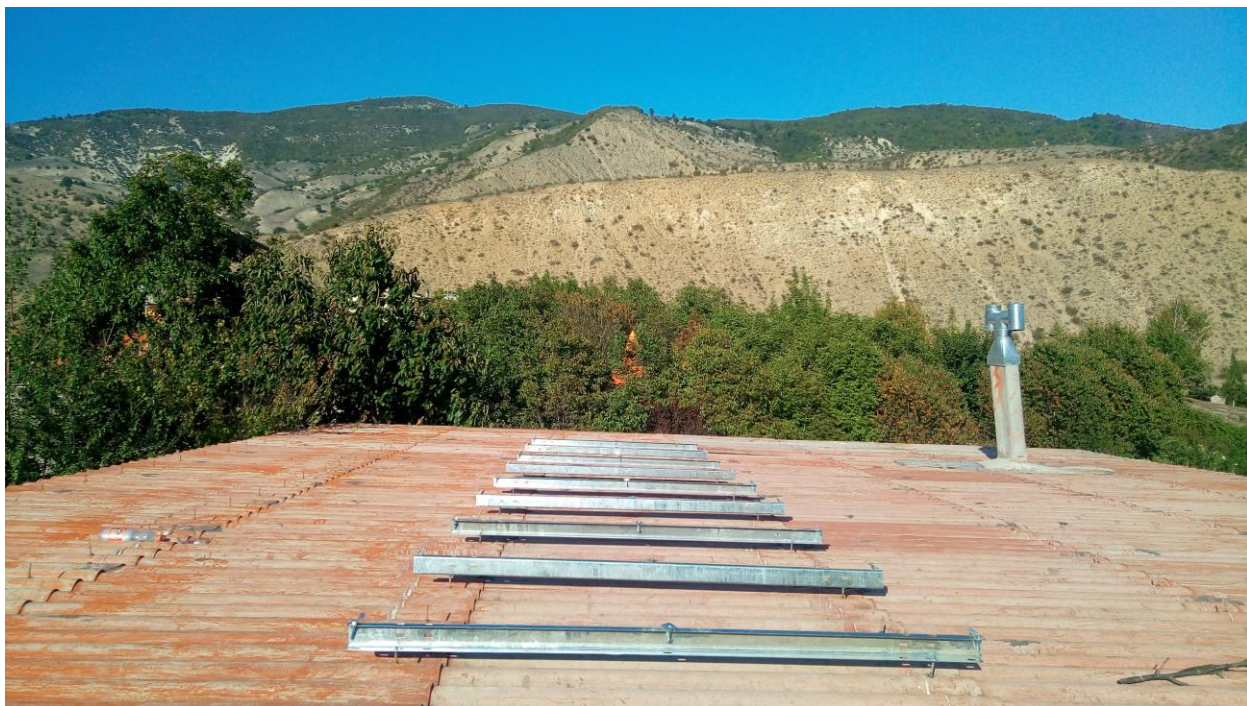
ریل های گالوانیزه متصل شده به سطح شیروانی
