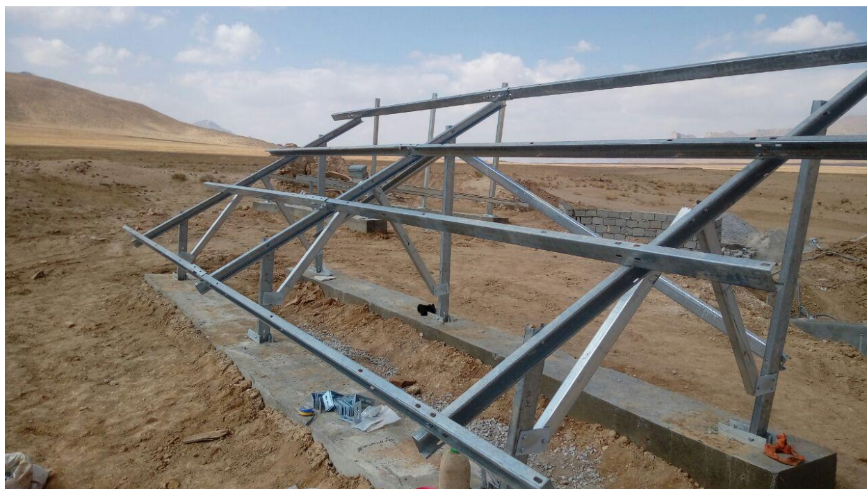
نمونه اجرای سازه بر روی فوندانسیون با استفاده از رول بولت و انکر بولت
